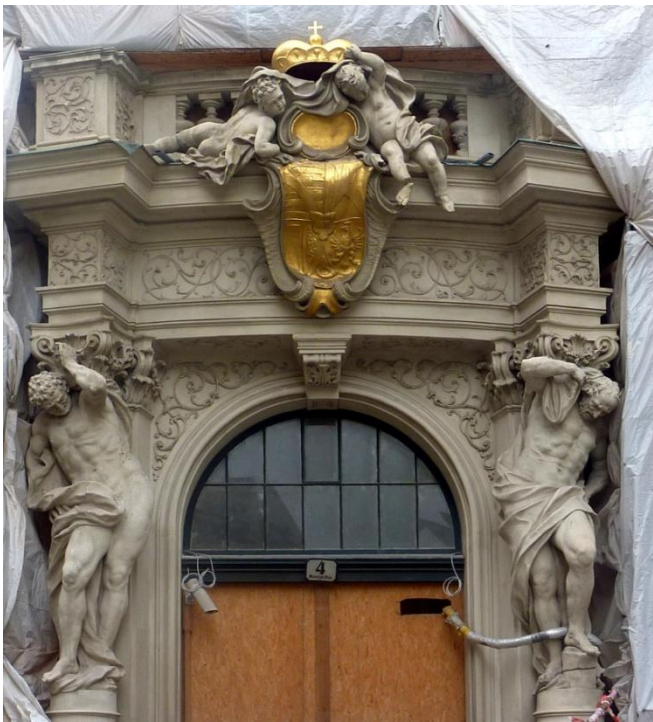
Liechtensteinský palác na Bankgasse od roku 2008 prochází celkovou rekonstrukcí – známý barokní portál
