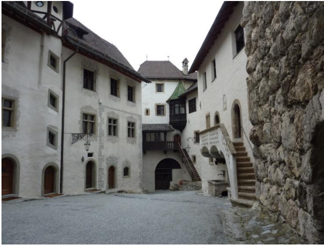
Třetí nádvoří hradu po rekonstrukci, která proběhla v letech 2008 - 2011
