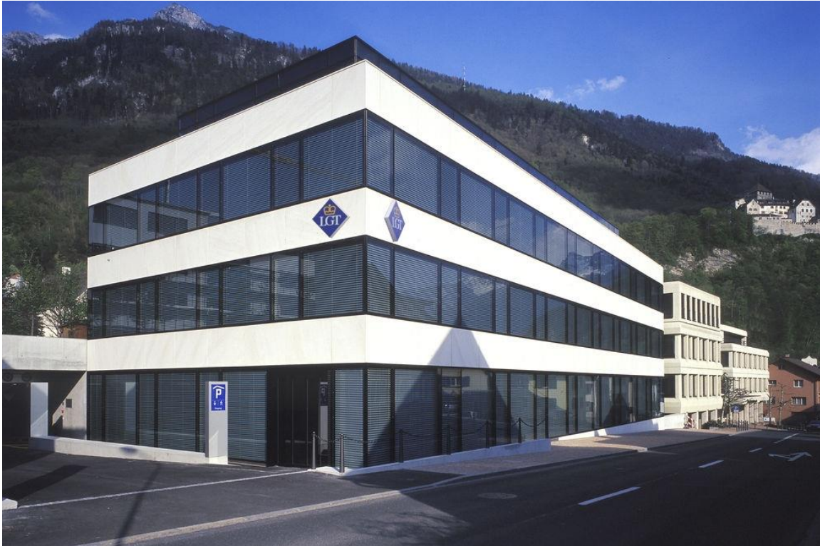
Moderní budova centrály LGT Bank leží nedaleko hradu Vaduz v Lichtenštejnsku
