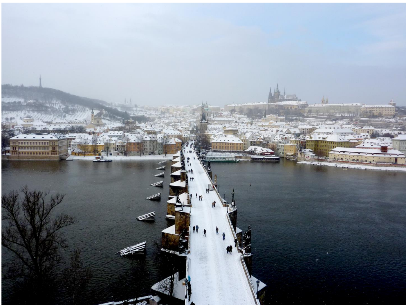
Pohled na Karlův most, Malou stranu a Pražský hrad ze Staroměstské mostecké věže, vlevo na břehu řeky Vltavy je bývalý Liechtensteinský palác (fotografie: Pavel Juřík)
